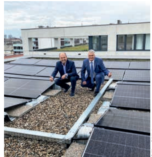
Auf dem Dach des Linzer Standorts von Wiener Städtische und Donau Versicherung erzeugt eine Photovoltaikanlage umweltfreundlichen Strom.
